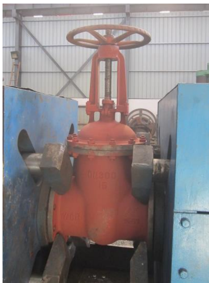
Item30 valve testing
